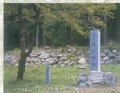
石垣と石碑 高さ2m、長さ80mの石垣があり、中央の大きな門の奥には城主の居館(御館)があったと考えられる。
